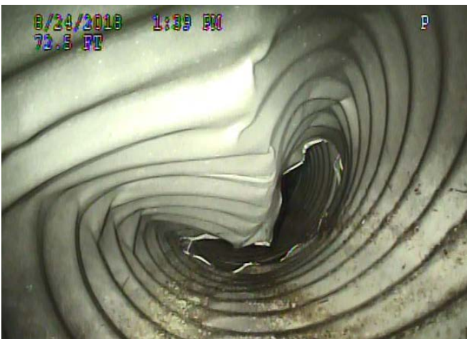
Hình ảnh CCTV quan sát bên trong một ống kim loại lượn sóng bị hỏng.
