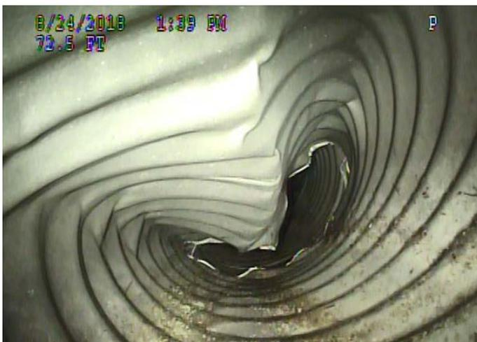
Изображение CCTV внутренней части поврежденной гофрированной металлической трубы.
